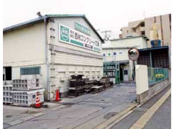
第2工場（プレキャスト製品工場）
